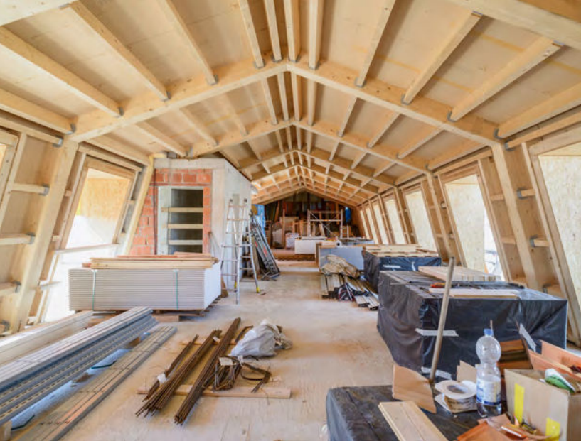
Abb. 42 Blick in das neu aufgerichtete Mansardgeschoss des südlichen Annexbaus.
